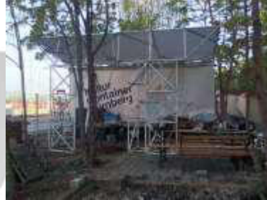
Bau der Überdachung
