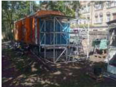
Bauwagen und Materiallagerbau
