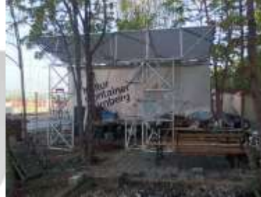
Bau der Überdachung
