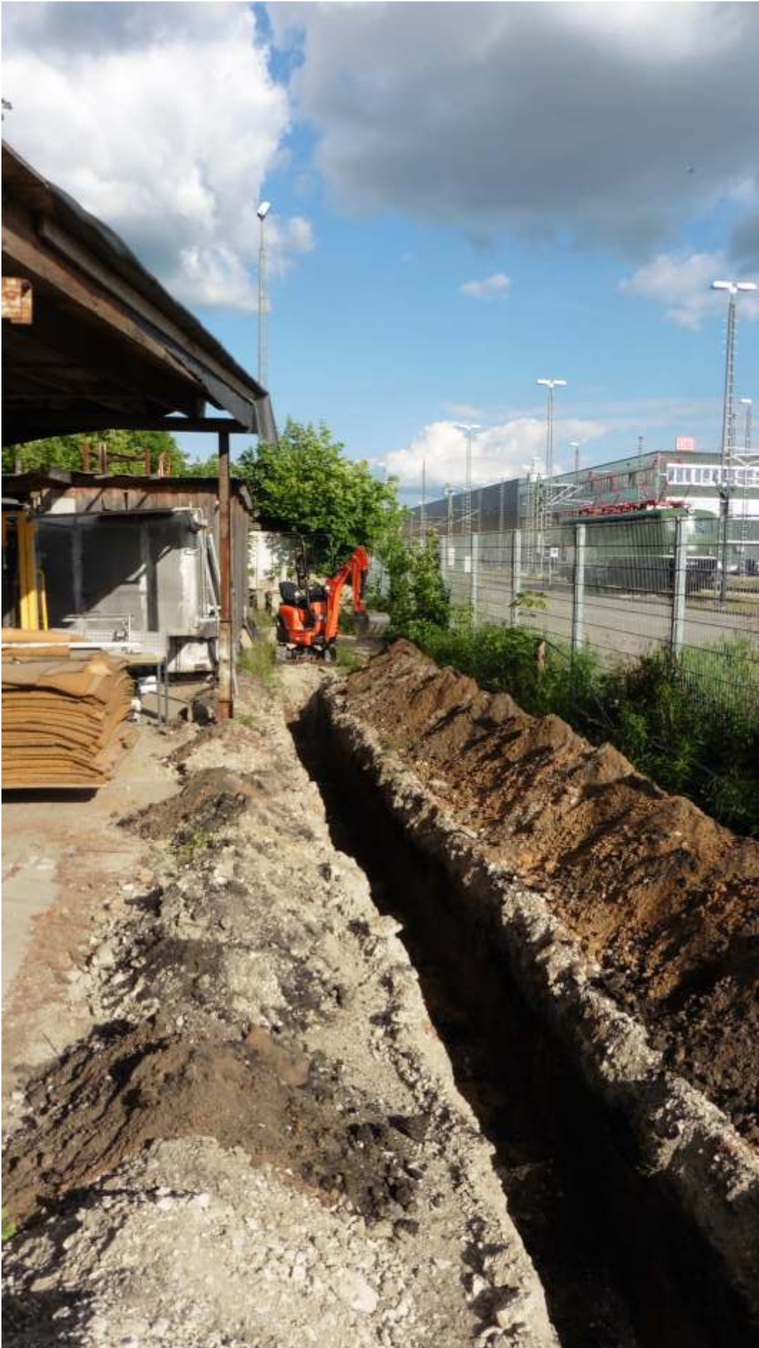
Wasser-Abwasserverlegung
